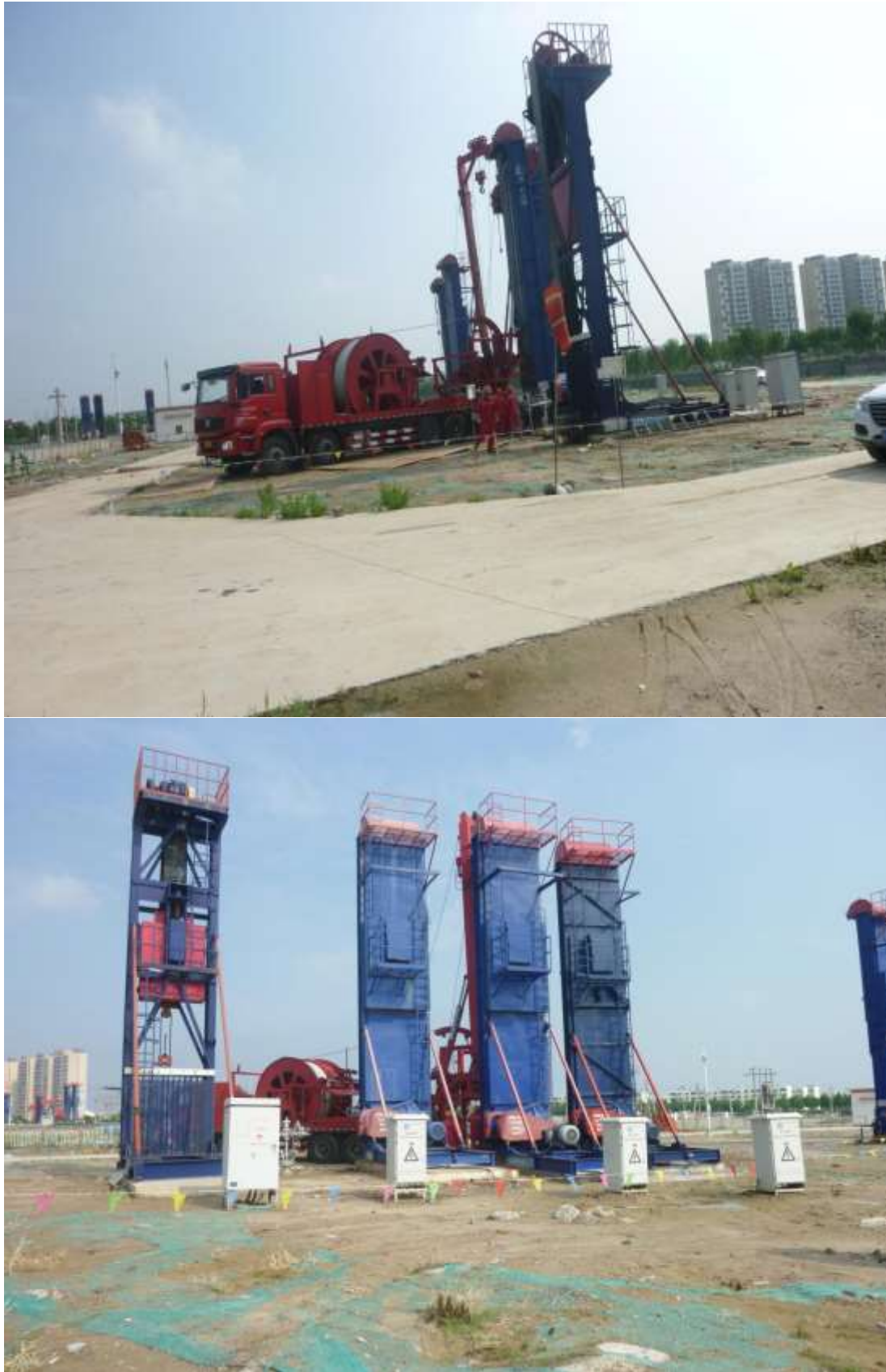
图 2-3 辛 50-斜 113 井作业现场
